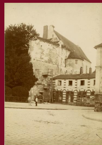
Dépôt de pompes à incendies , Don Gassies, 1856-1896
